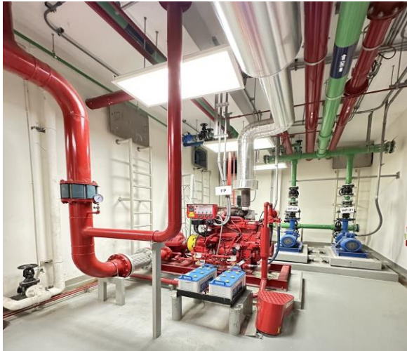
ระบบน้ำสำรอง และ Fire Pump
